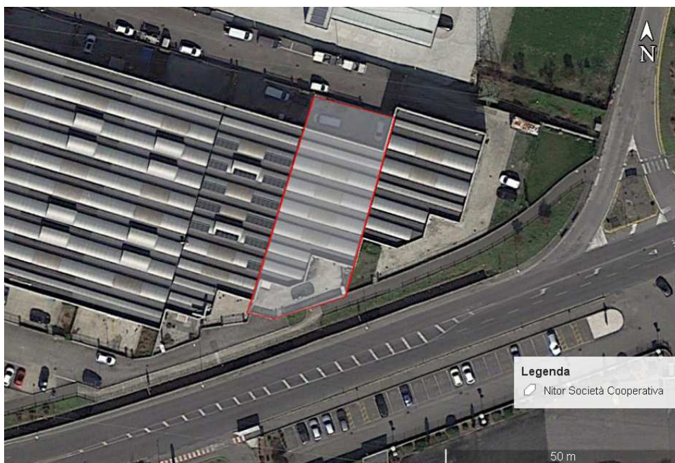
Sede legale ed operativa – Aree uffici e magazzino
